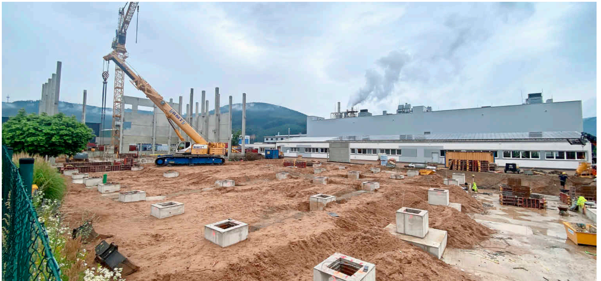
Schon im April haben die Arbeiten am neuen Technik-Gebäude des Hygienepapierherstellers Fripa in Miltenberg begonnen. Wenige Meter davon entfernt hat man am Freitag den Startschuss für die nächste Investition gegeben – und zwar für den Bau einer neuen Logistikhalle im Auweg in Großheubach. Foto: André Breitenbach
