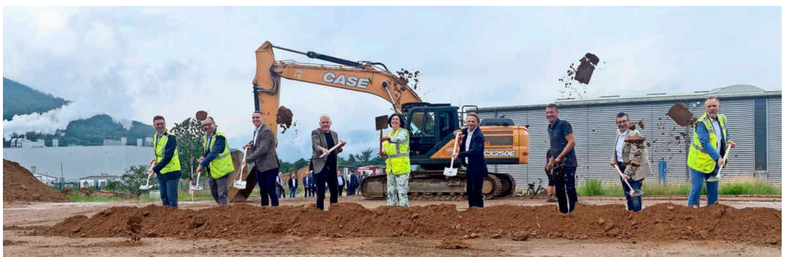
Spatenstich für die neue Logistikhalle. Im Bild sind unter anderem Verena Queck-Grimm, Torsten Bahl und Jan Wohlbold von der Fripa-Geschäftsführung, Hubertus Dreßler (Bauunternehmen) und Architekt Klaus Wolf. Foto: André Breitenbach
